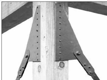
Détails d'un montant d'angle large : Raccord à bande BNF avec connecteur de couplage BNKK sur le montant. Le pli a été entaillé dans le montant.
