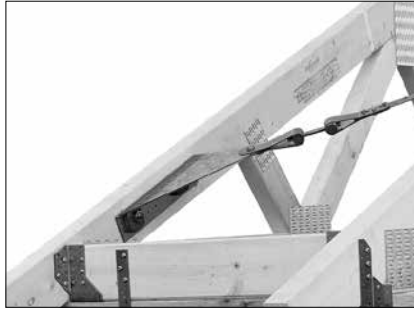
Détails sur le point de profilé inférieur : Raccord à bande BNG avec tendeur BNSPxxB. Fixation : sécurisée latéralement contre le basculement par des blocages avec des boulons et des chevrons.
